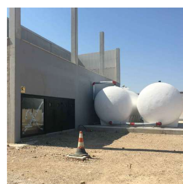
VISTA 04 ACCESO Y DEPÓSITOS PABELLÓN MULTIFUSOS
